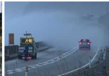
写真③ 越波による通行規制 （村上市府屋 H26. 12. 17）
