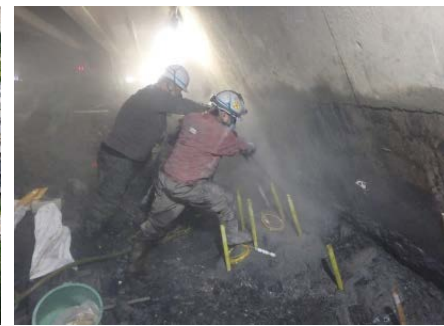
写真5: 発破併用掘削状況
