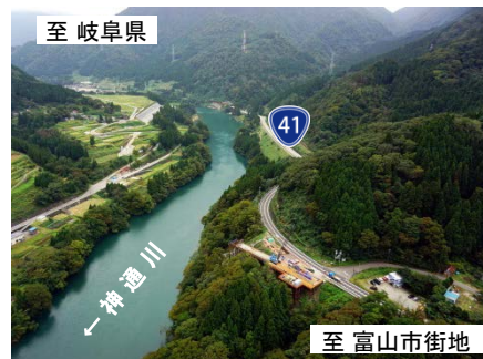
写真1：事業中区分 （富山市片掛地先）
