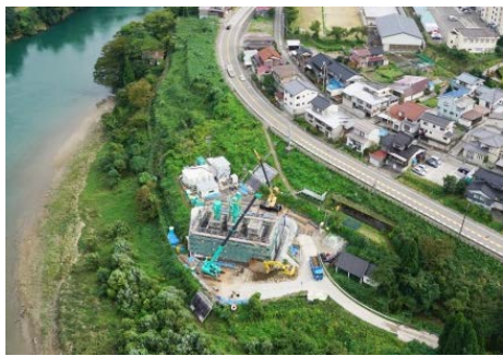
写真4: 猪谷橋施工状況
