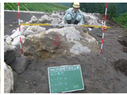
写真7: 巨石の採寸状況
