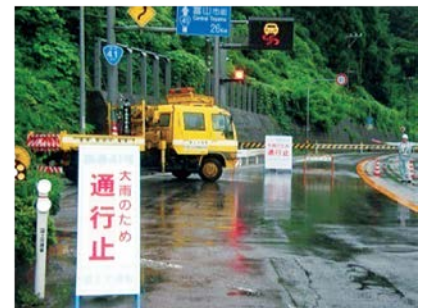
写真8: 国道41号の通行規制状況(富山市街地方面を望む)
