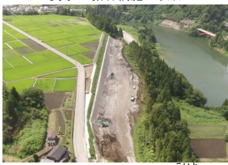
写真6: 切土施工状況(富山市小糸地先)
