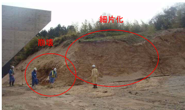
風化による細片化と崩壊
