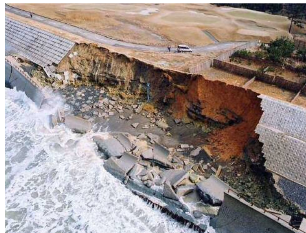
《②堤防空洞化による天端陥没状況(写真1-3)》
