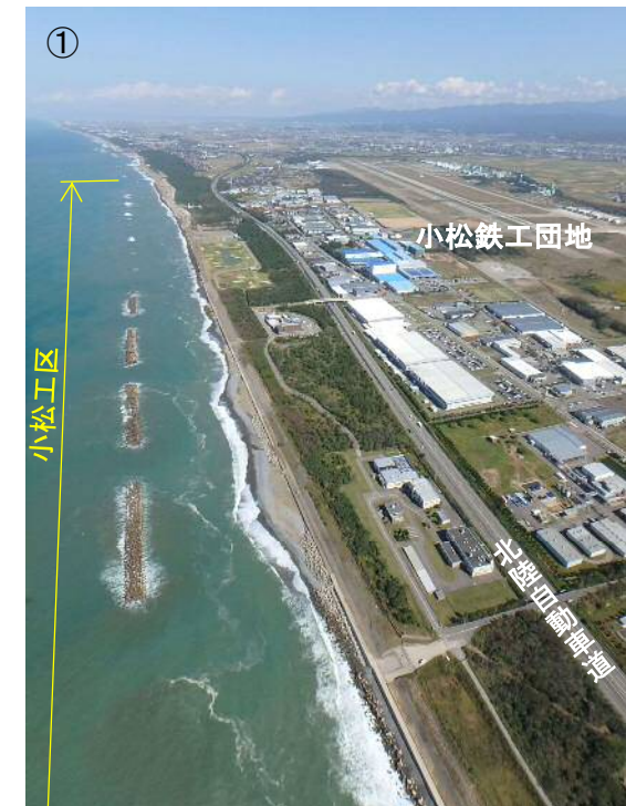
石川海岸 (小松工区) の状況
