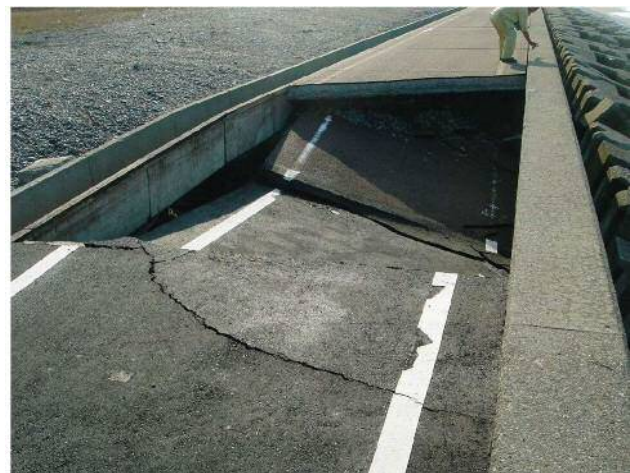
《②堤防空洞化による天端陥没状況(写真1-3)》
