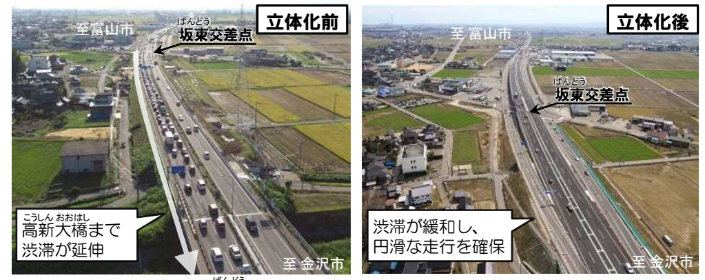
写真：国道8号 坂東交差点の交通状況 (金沢市方向より富山市方向を望む)
