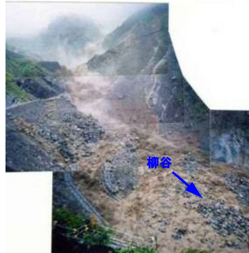
やなぎだに 柳谷の土石流災害状況
