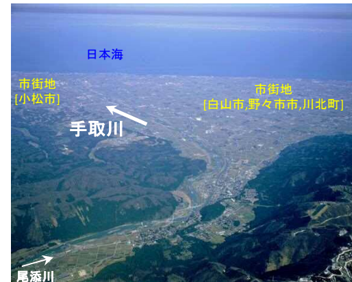
図3-2 保全対象 [手取川扇状地に発展する市街地]
