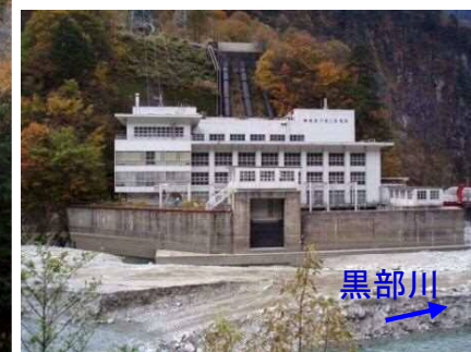
黒部川第二発電所
