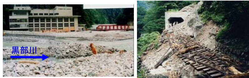
土砂流出により埋没した 黒部川第二発電所 (災害前から川底が約10m上昇)
