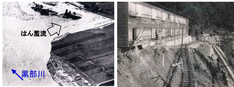
堤防決壊状況 黒部川右岸[入善町福島地先]
