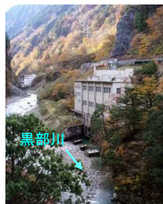
黒部川第三発電所
