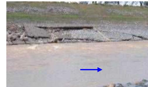
堤防護岸被災及び根固流出
