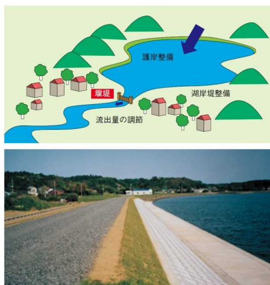
湖岸堤(霞ヶ浦開発、水資源機構)
