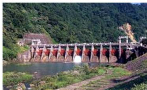
庄川用水合口ダム
