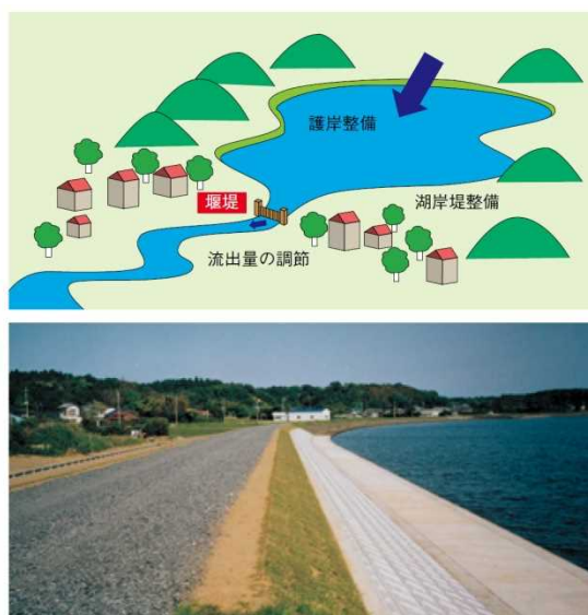
湖岸堤(霞ヶ浦開発、水資源機構)
