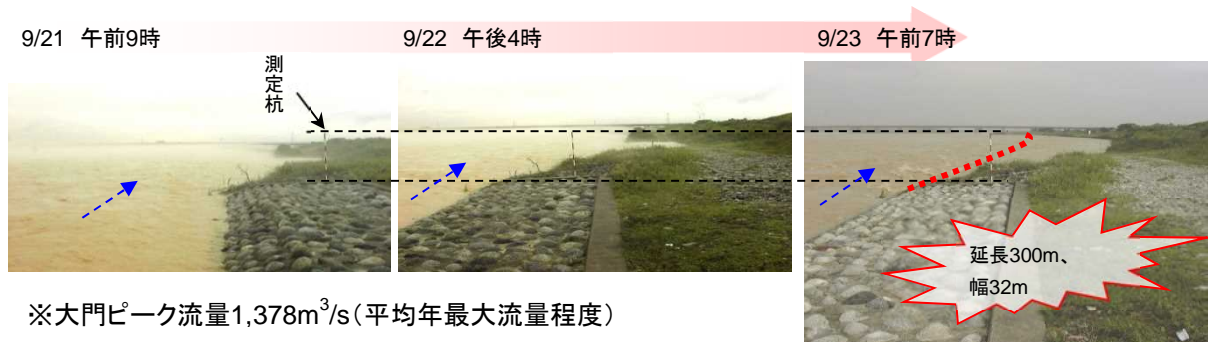
図 2.2.18 平成11年9月洪水における被災状況（平均年最大流量洪水時）
