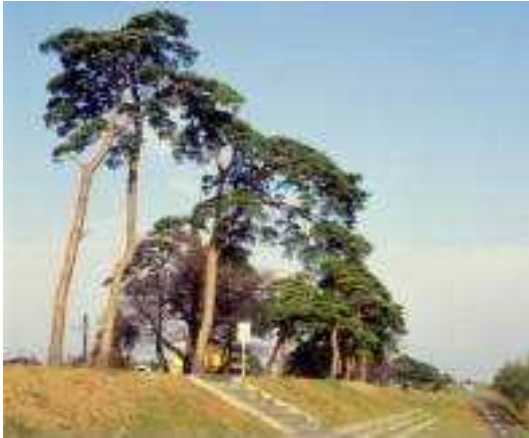
図 2.2.1 松川除堤防（正徳 4 年完成）
