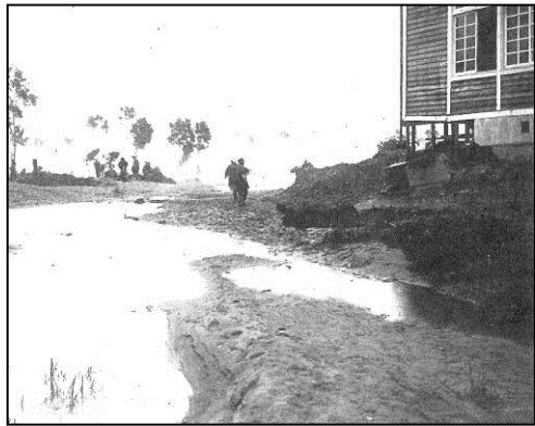
庄川右岸氾濫状況 (浅井小学校講堂西南側)
