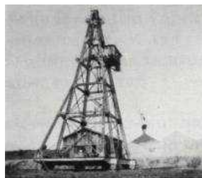
図 2.2.3 タワーエクスキャベーターによる河床掘削
