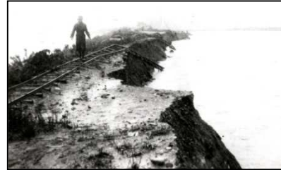
大門町(現射水市)国鉄(現あいの 風とやま鉄道)橋梁付近被災状況
