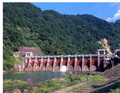
図 2.2.9 庄川用水合口ダム
