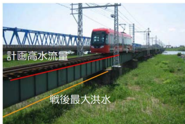
図 2.2.22 万葉線橋梁と計画高水流量・戦後最大洪水時水位の関係
