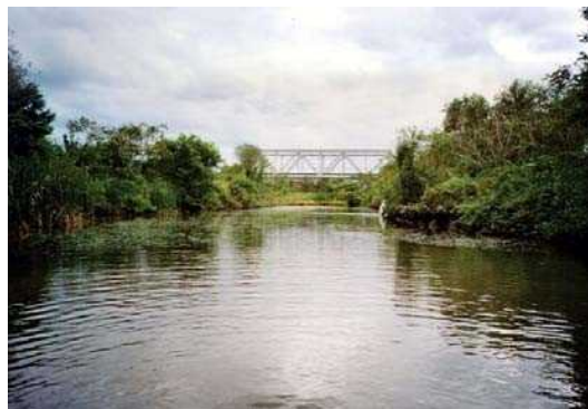
JR 北陸本線橋（6.6k 付近）下流左岸の池
