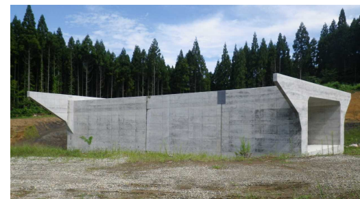
【写真②: 沼地区函渠が概成】
