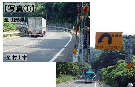
大内淵地区の線形不良箇所 (R=85)
