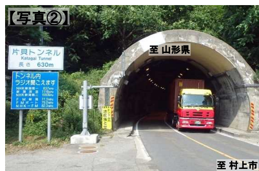
幅員が狭く見通しも悪い片貝トンネル(延長630m)
