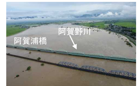
阿賀浦橋、JR羽越線橋梁付近
