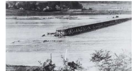
松浜橋の流出(現:新潟市北区、東区)
