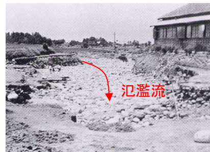
氾濫流による洗掘状況(黒部市荻生地先)
