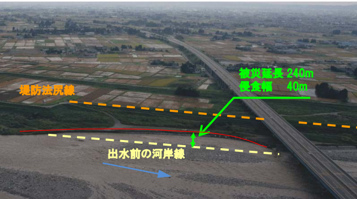
出水による河岸侵食（左岸10.6K）
