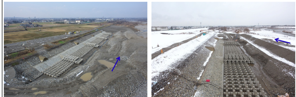
朝日地区（根継ぎ護岸工）整備状況
