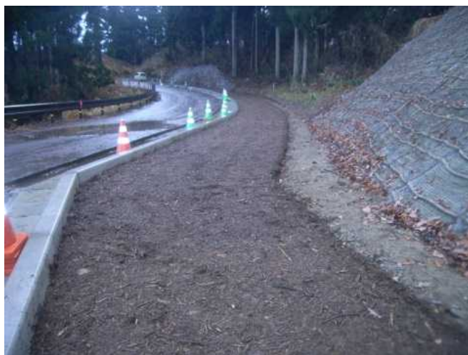
▲敷均し・転圧のみのウッドチップ舗装[里山フィールドミュージアム内園路]
