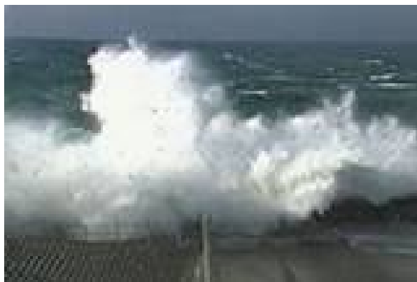
護岸の越波状況 ①
