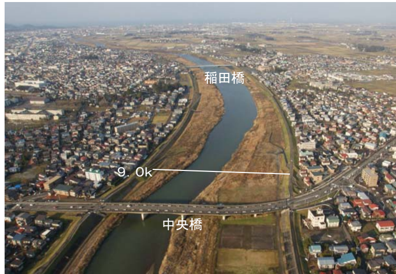
河道掘削予定箇所(稻田橋～中央橋付近)
