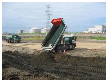
埋立地への土砂運搬状況写真
