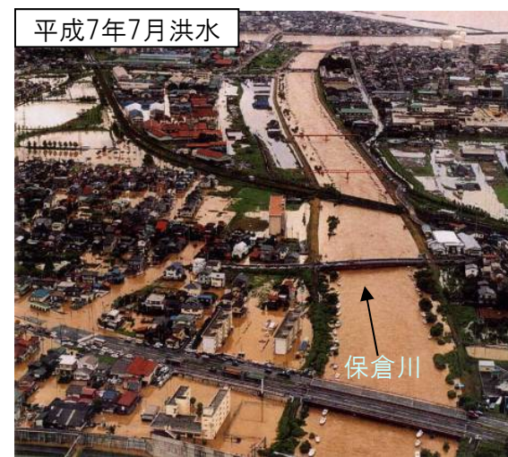
上越市春日新田地先被災状況
