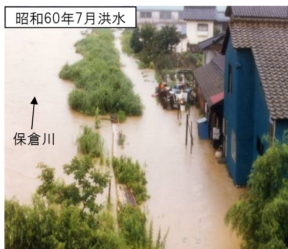
上越市港町地先被災状況
