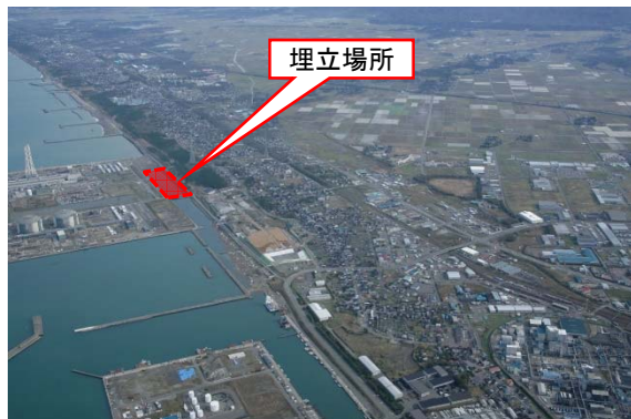
港湾埋立施工位置斜め写真
