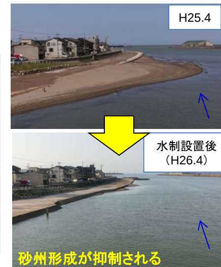
仮設水制の試験施工状況(写真15-2)
