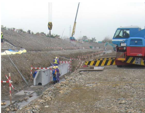
クレーンによる二次製品据え付け
