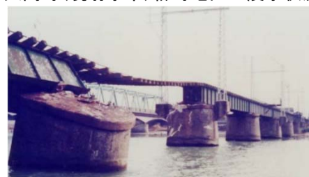
加越能鉄道落橋
