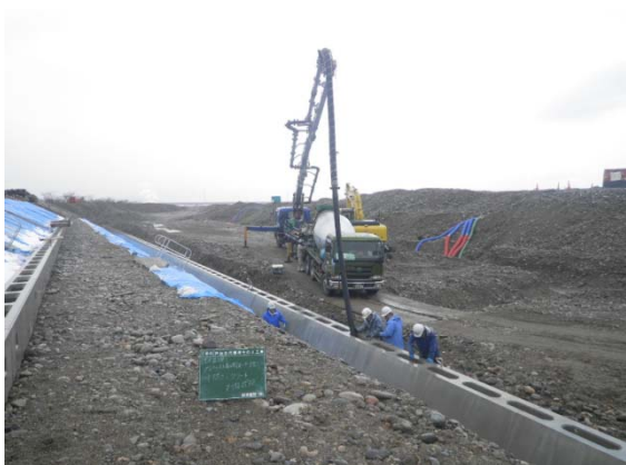
中詰コンクリート打設
