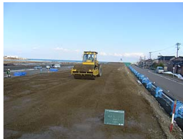
情報化施工の試験施工(写真18-3)
