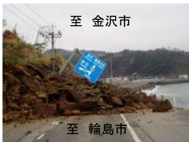
国道249号の被災状況 (能登半島地震時)
