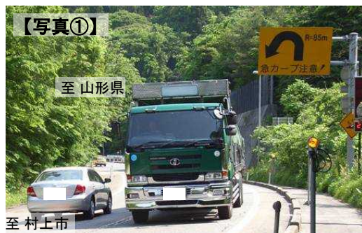
大内測地先の線形不良箇所 (R=85)
