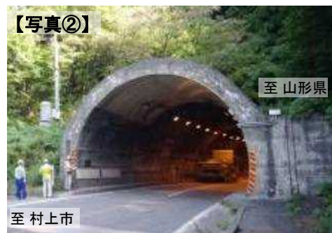
幅員が狭く見通しも悪い片貝トンネル (L=630m)
