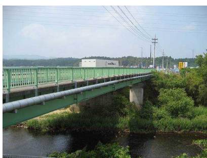
加賀大橋 (L=64.9m) S 34年架橋
