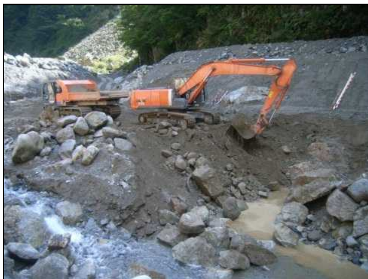
土砂の掘削状況(黒薙川第2号下流砂防堰堤の基礎部)
