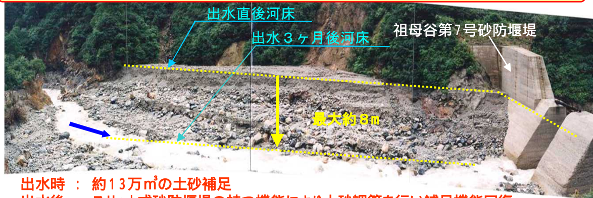
H7.7祖母谷第7号砂防堰堤の土砂補足・調節状況
