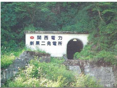
新黒部川第二発電所
