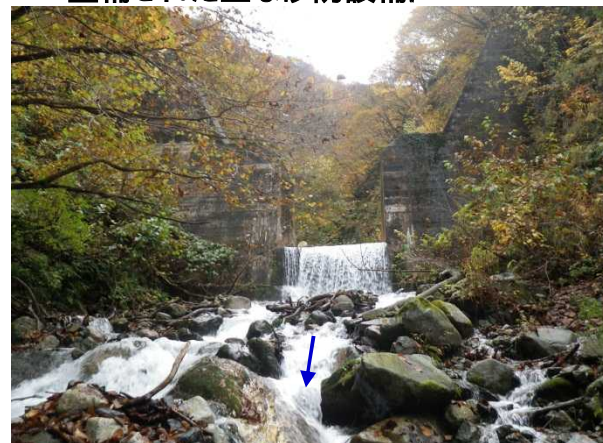
野坊瀬谷第3号砂防堰堤
