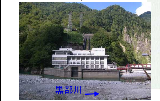
黒部川第二発電所 (現在)
