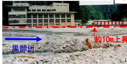
土砂流出により埋没した黒部川第二発電所
