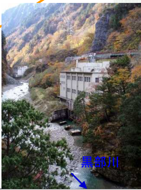
黒部川第三発電所
