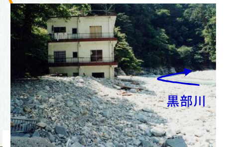
土砂流出により埋没した猿飛山荘
