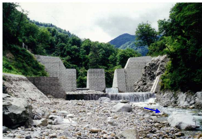
小黒部谷第1号砂防堰堤
