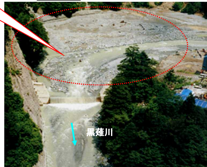
黒薙川第3号砂防堰堤
