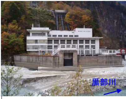
黒部川第二発電所
