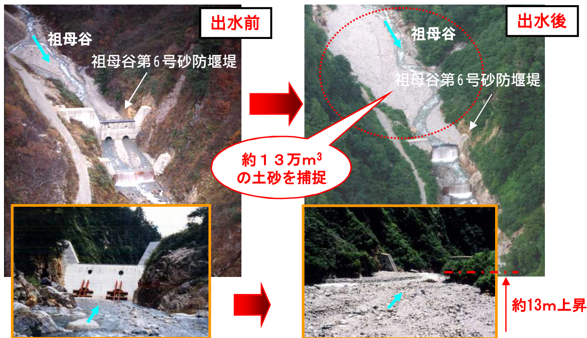
H7.7祖母谷第7号砂防堰堤の土砂補足・調節状況
