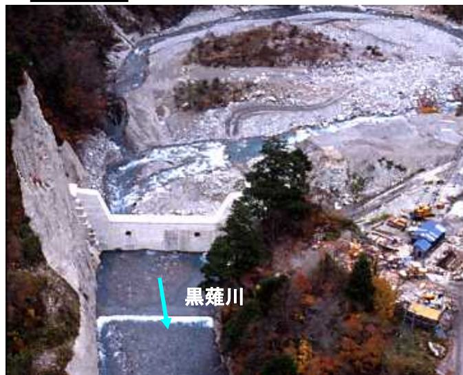
黒薙川第3号砂防堰堤
