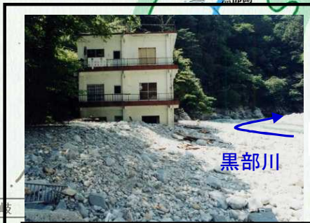
土砂流出・堆積により被災する猿飛山荘の状況 (H7災害)
