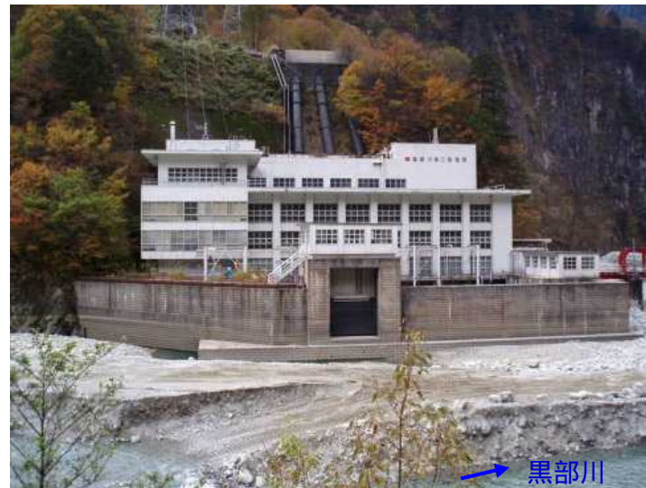
黒部川第二発電所
