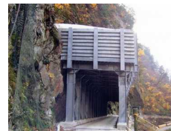
資材運搬道路の安全対策（落石対策）
