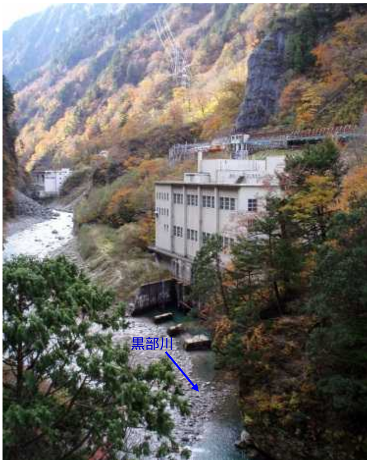
黒部川第三発電所
