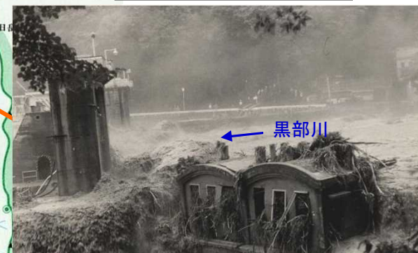
あいちと 増水時の愛本堰堤
