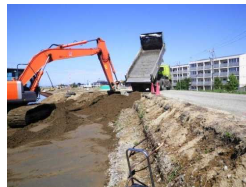
掘削土砂の築堤材としての有効利用
