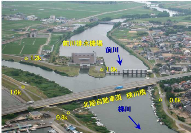
前川排水機場の稼働状況（図9-1）
