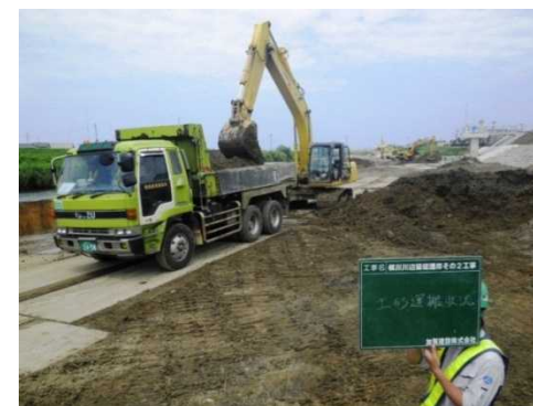
掘削土砂積み込み状況
