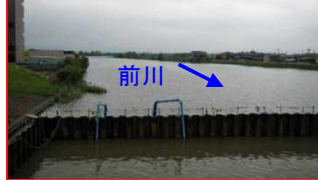
小松新橋上流右岸付近の状況
