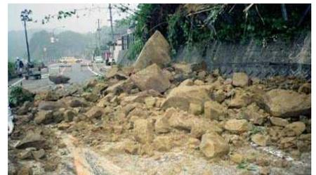
写真②: 落石による通行止め (氷見市中田: 平成3年6月30日発生)
