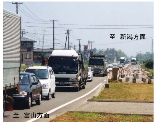
暫定2車線区間の渋滞状況 【下荒浜交差点付近】(新潟方面を望む)
