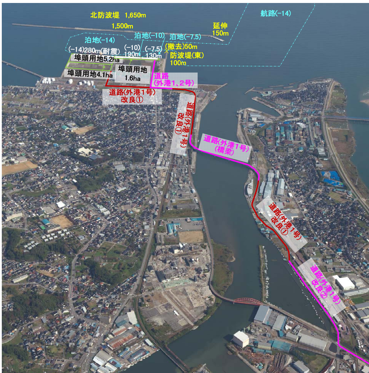
図 2 - 1 国際物流ターミナル整備事業構成施設 (H23. 11 撮影)
