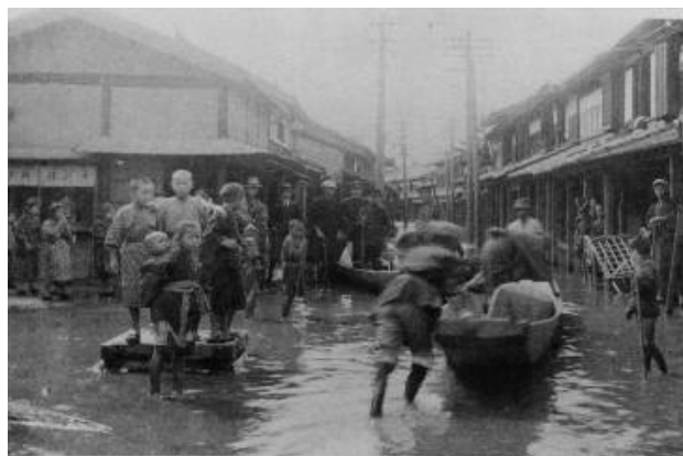
木津切れにより冠水した横越町内
