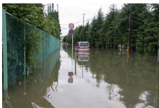
支川太田川の浸水状況
