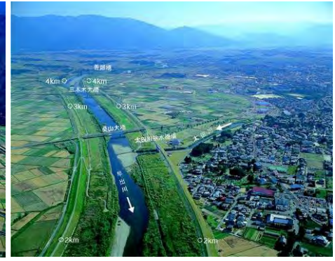
早出川捷水路
