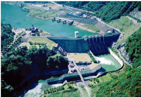
大川ダム全景
