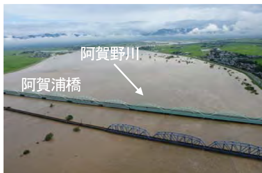
阿賀浦橋、JR 羽越線橋梁付近
