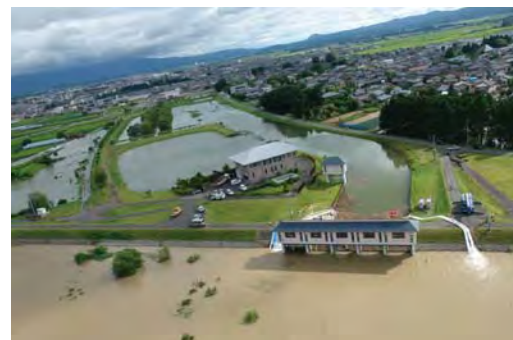
太田川排水機場排水状況
