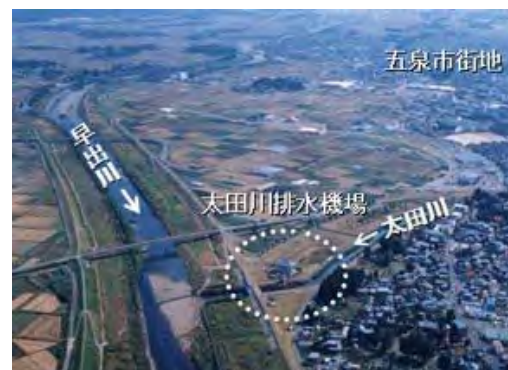
太田川排水機場付近
