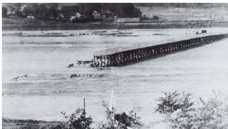
松浜橋の流出(現:新潟市北区、東区)
