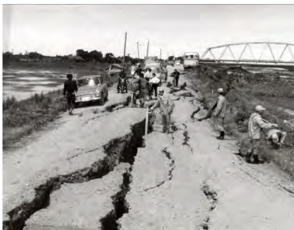
堤防被害状況
