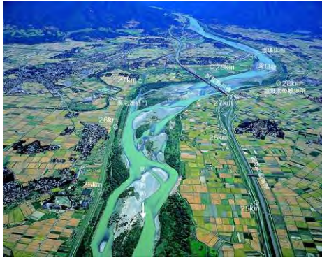
阿賀野川上流部 (25km 付近)
