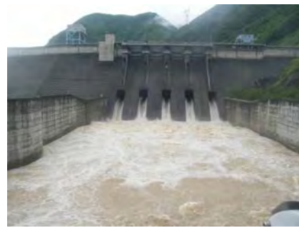
大川ダム洪水調節状況
