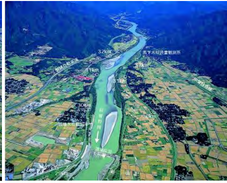
阿賀野川上流部 (29km 付近)
