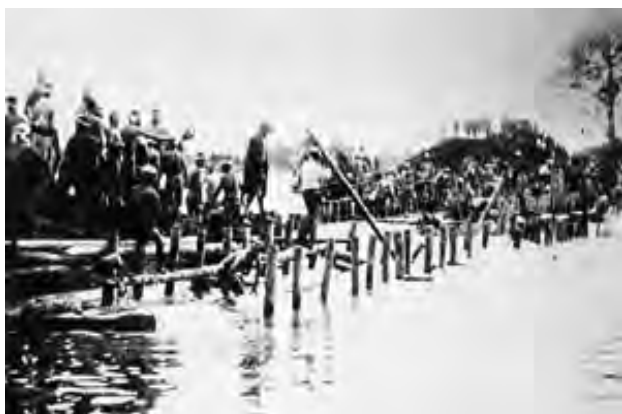
木津の破堤箇所を復旧する様子
