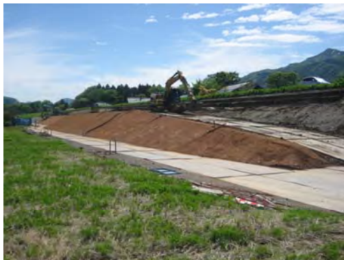
盛土材への利用状況(堤防盛土)
