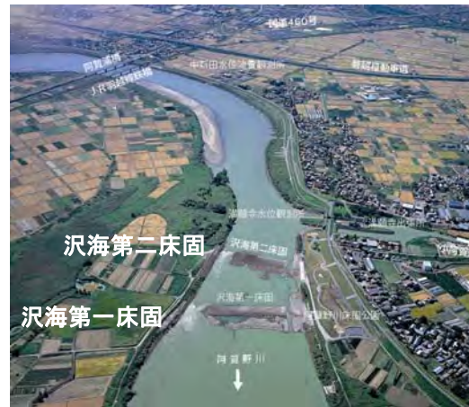
沢海床固の状況
