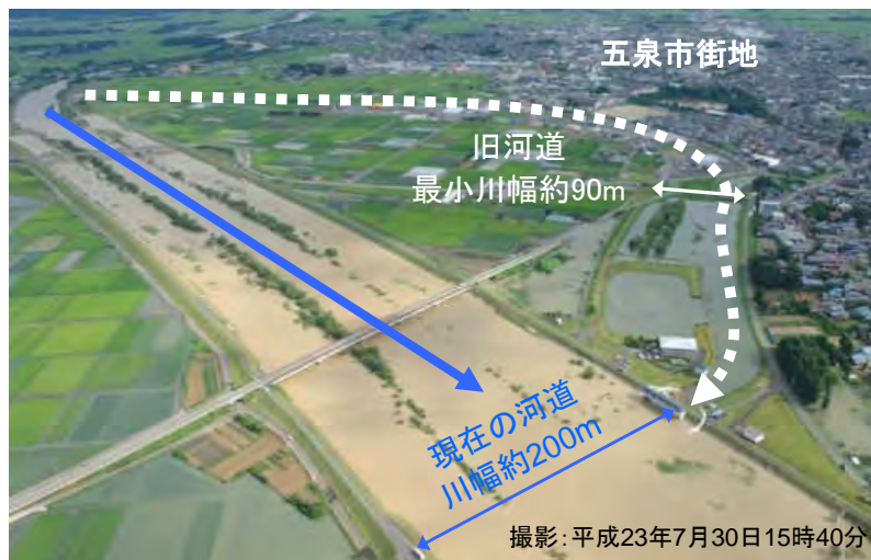
早出川捷水路
