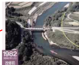
泡の巻地区 (改修前)
