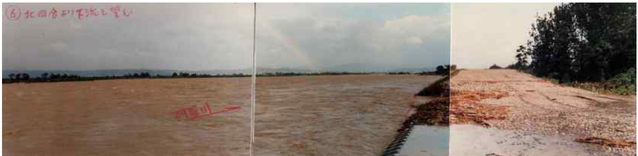
出水状況 北四合地先より下流を望む
