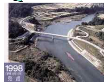
泡の巻地区 (改修後)
