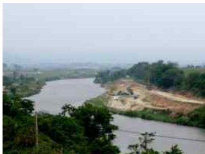
下流狭窄部改修事業（津尻地区）
