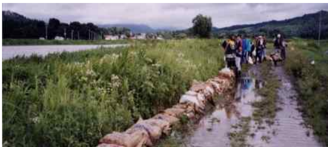
水防活動 (旧宮川越水箇所)
