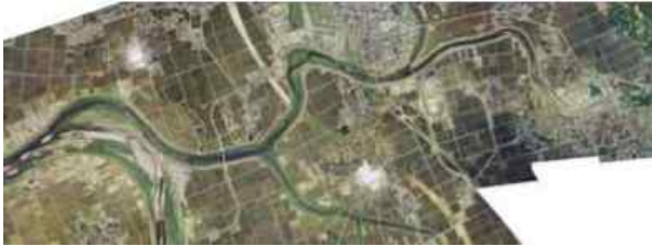
日橋川改修による流路の変更
