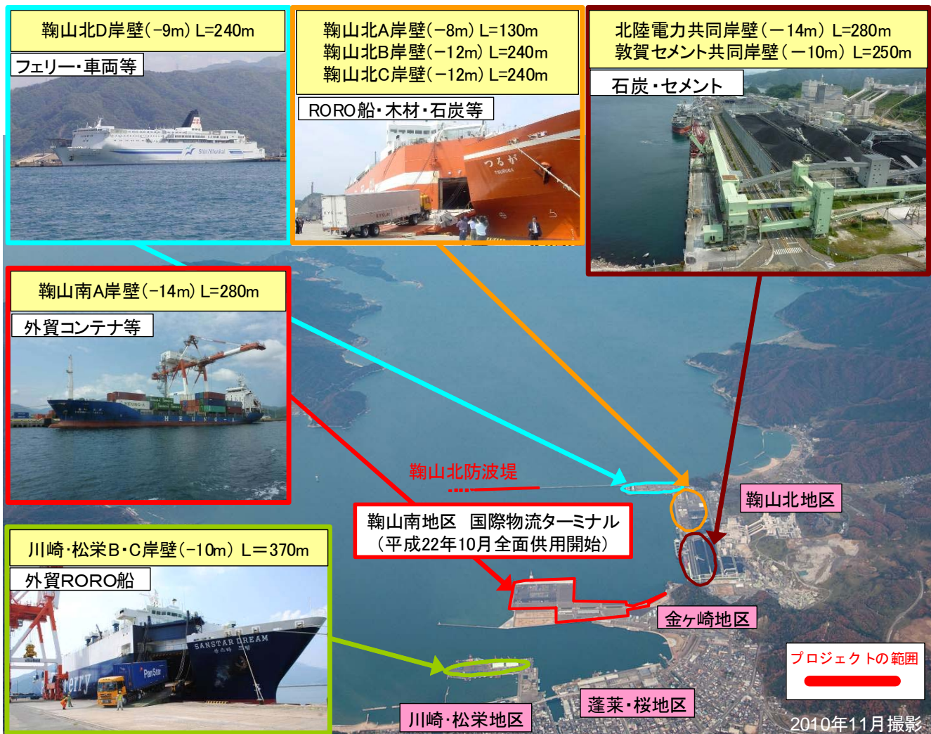
写真 1-1 敦賀港における主な施設と貨物
