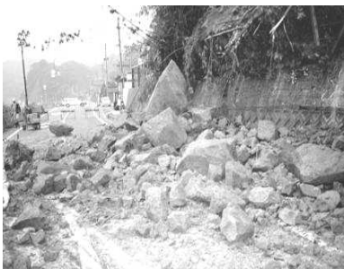
写真A：落石による通行止め (氷見市中田)
