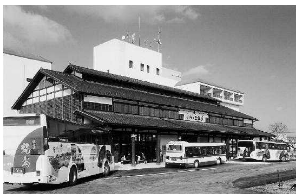
旧輪島駅を改修した道の駅「輪島」
