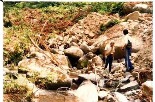
豪雨による溪流内土砂崩落(姫田川支溪流)
