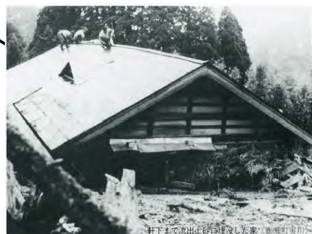
軒下まで土砂に埋没した家屋(実川) 軒下まで流出土砂に埋没した家(新発田実川)
