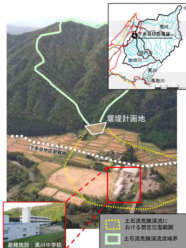
下赤谷砂防堰堤
