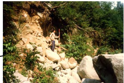
崩落した三光川溪流内
