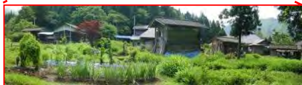
保全対象集落が連なる滝谷地区
