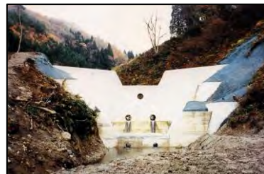
熊出川砂防堰堤 (昭和57年度完成、加治川1基目)
