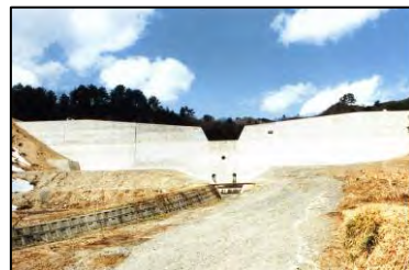
久保川砂防堰堤 (昭和54年度完成、胎内川1基目)
