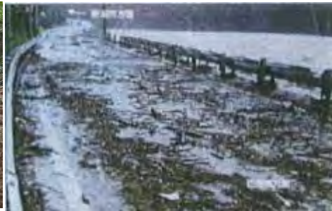
国道113号線道路冠水(平成16年7月)
