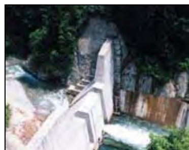
実川第1号砂防堰堤 (平成6年度完成、実川1基目)
