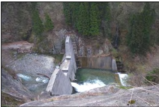
実川第1号砂防堰堤(実川)
