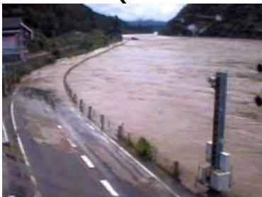
豪雨により国道49号が冠水(平成23年7月：阿賀野川)
