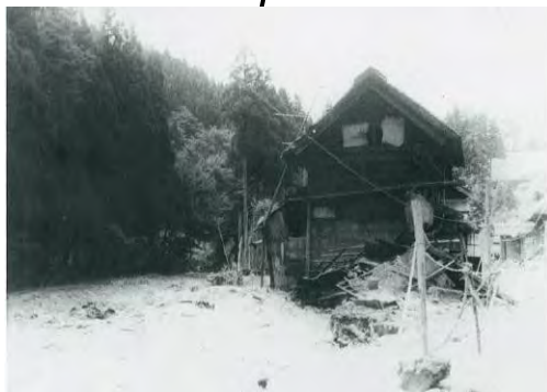
氾濫で倒壊寸前となった家屋(馬取川)
