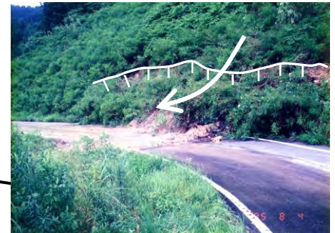
集中豪雨により土砂崩落した滝谷地区(平成7年8月)
