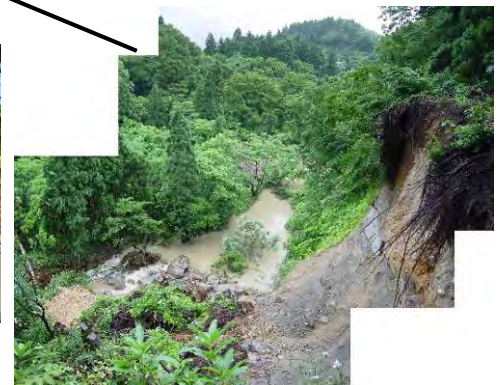
法面崩壊により棚橋川へ土砂流入(平成17年6月)
