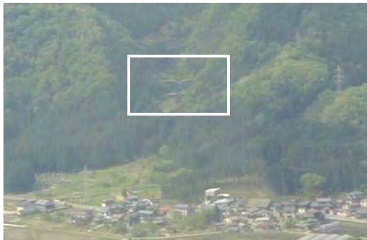
坪穴沢砂防堰堤 (胎内川水系)
