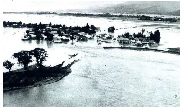
加治川(右岸)破堤により浸水した新発田市内
