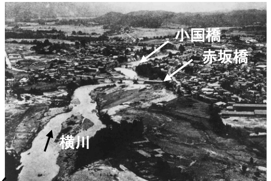
洪水後の小国町中心部の状況
