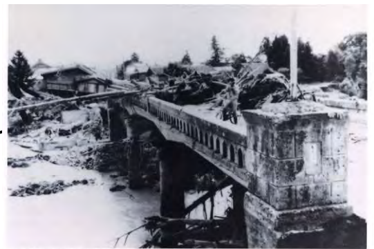
流木の山となった小国橋
