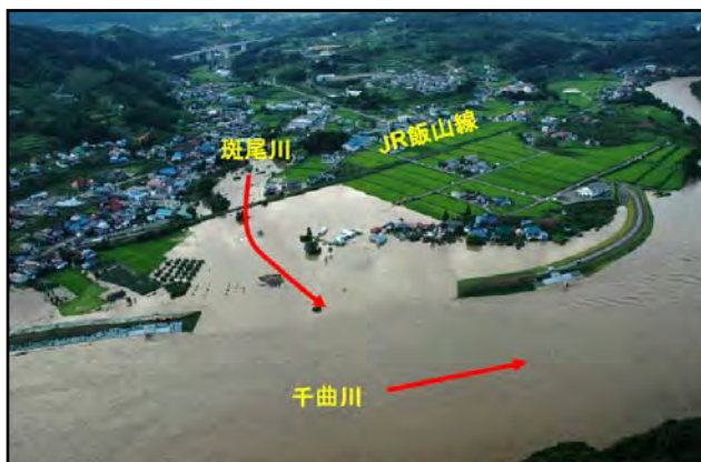
中野市替佐地区(堤防整備中)の浸水状況
