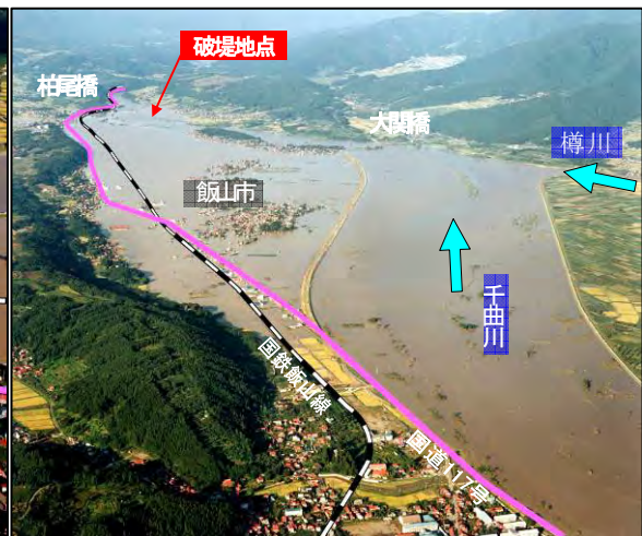
飯山市戸狩・常盤地区の浸水
