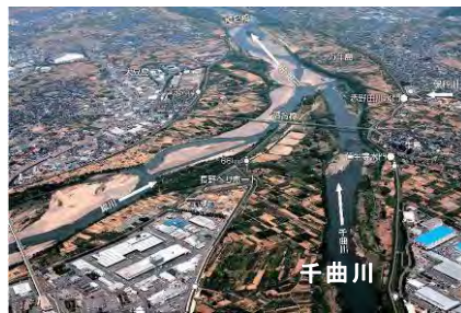
千曲川 65k 付近(千曲川・犀川合流部)
