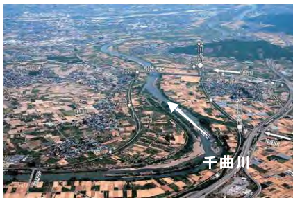
千曲川 77k 付近(岩野橋付近)
