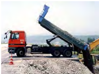
発生土搬入状況
