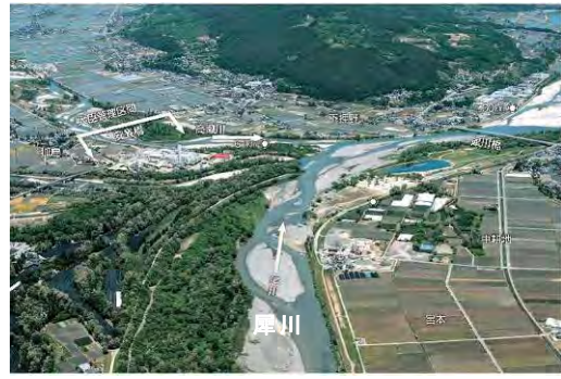
犀川 60.0k 付近 (高瀬川・穂高川合流点)
