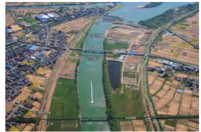
大河津分水路 0.0k 付近
