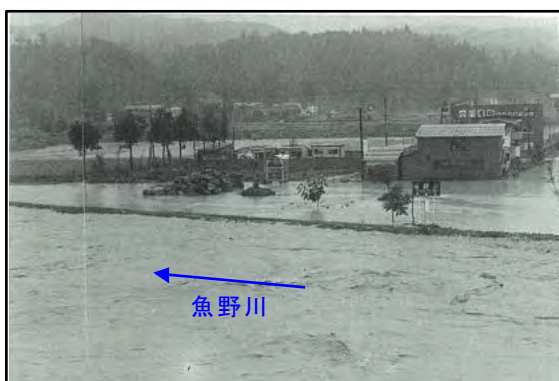
堀之内地区 溢水寸前の魚野川の状況
