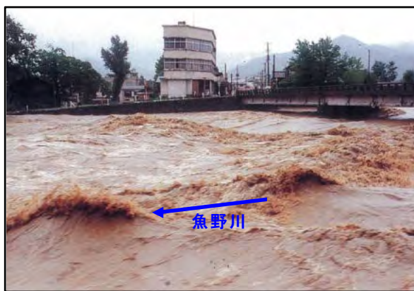
小出地区柳生橋の状況
