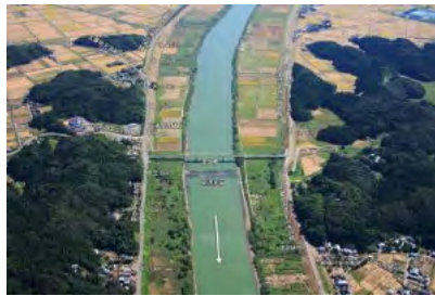
大河津分水路 5.0k 付近
