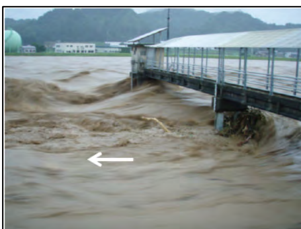
魚野川堀之内水位観測所付近の様子
