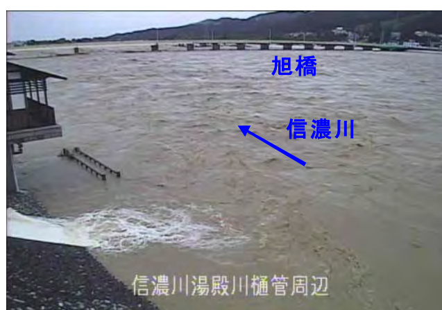
信濃川湯殿川樋管周辺の様子
