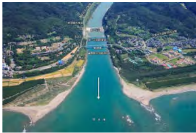
大河津分水路河口付近
