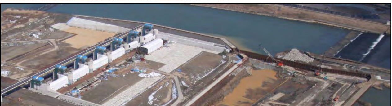
工事進捗状況(平成23年3月撮影)
