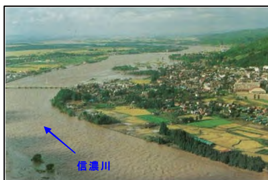
東小千谷地区旭橋の状況
