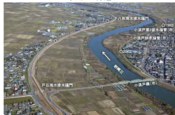
本川 20k 付近 小須戸橋合流点
