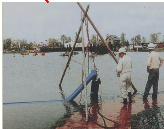
湛水した都市緑化フェア会場
