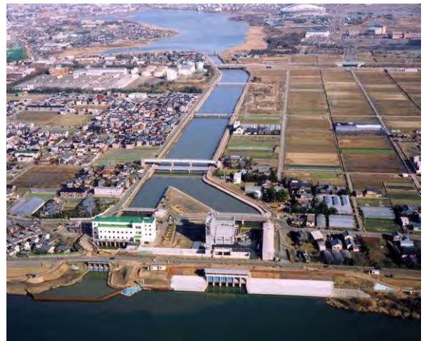
鳥屋野潟排水機場
