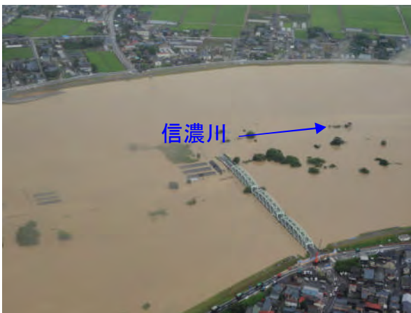
小須戸橋付近の出水状況 (H23. 7. 30 撮影)
