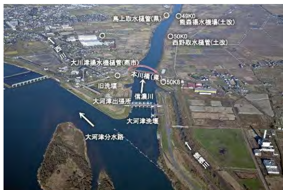
本川 50. 8k 付近 可動堰・洗堰
