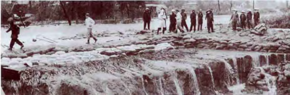
昭和 53 年被害状況 (坂井橋上流左岸破堤)
