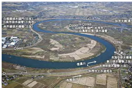
本川 33k 付近 蛇行区間
