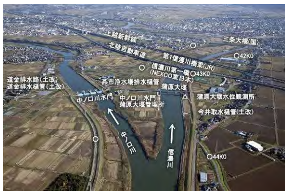
本川 44k 付近 中ノ口川分派点
