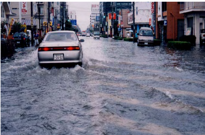
幹線道路の浸水状況 (新潟市笹出線)
