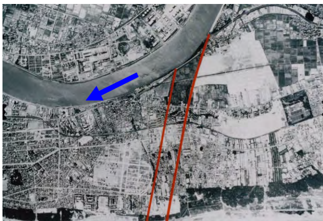
関屋分水路 掘削前
