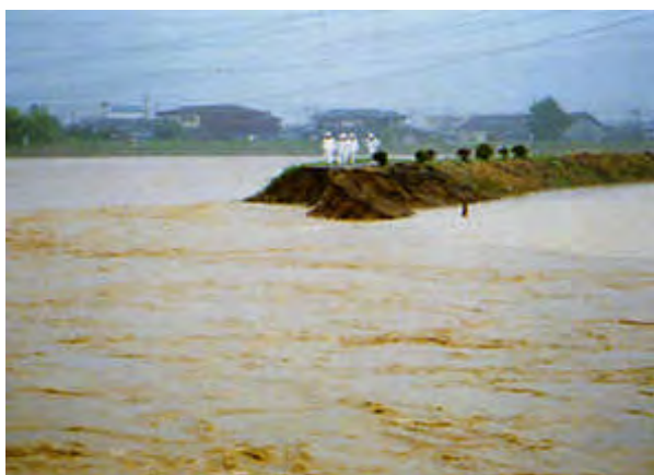
五十嵐川の破堤状況
