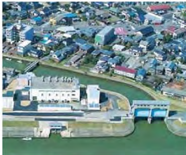
西川排水機場
