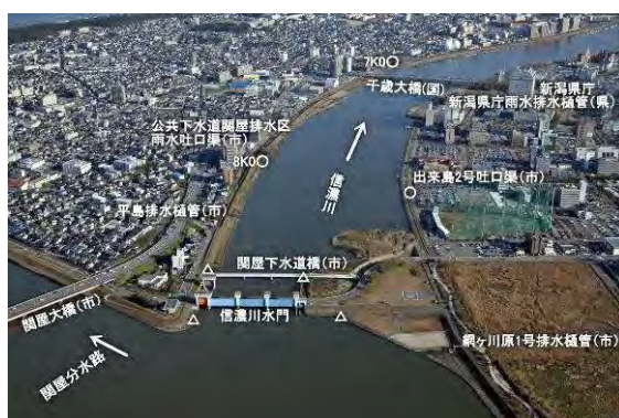
本川下流分派点 8k 付近 信濃川水門
