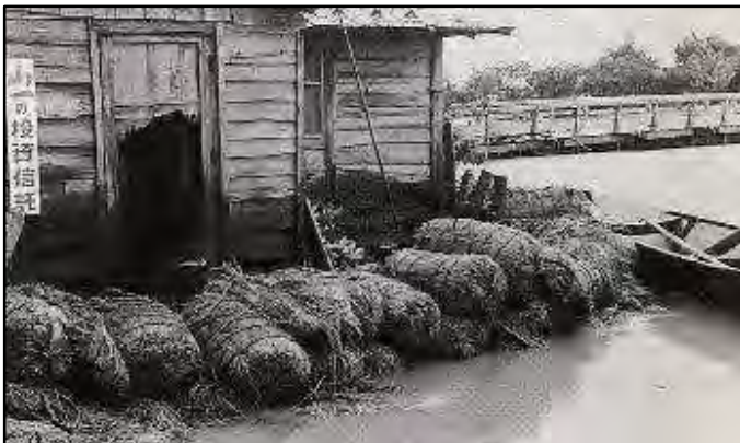
米俵により水防作業を行った中ノ口川とその沿川
