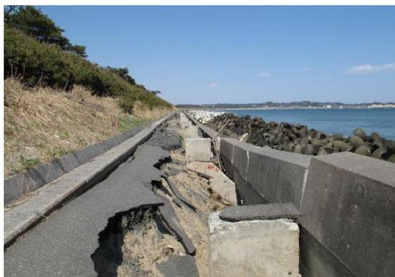
図－14. 護岸の被災例
