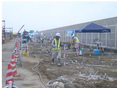
図－16. 護岸の吸出し防止兼液状化対策施工状況
