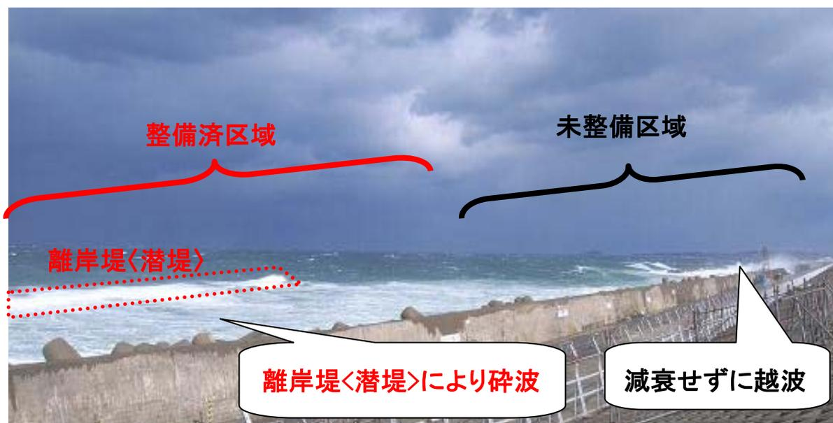
図－10. 離岸堤<潜堤>の整備効果
