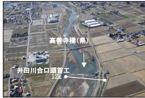
井田川合口頭首工付近
