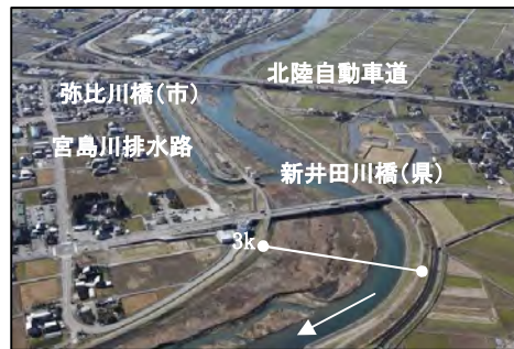
新井田川橋付近
