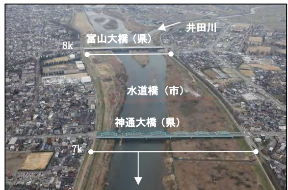
神通大橋付近
