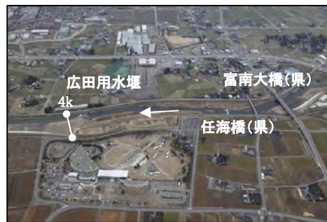
広田用水堰付近
