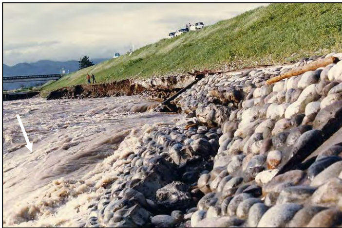
上段写真囲み箇所の近景
