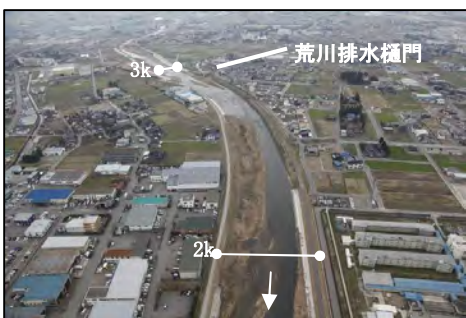
荒川排水樋門付近
