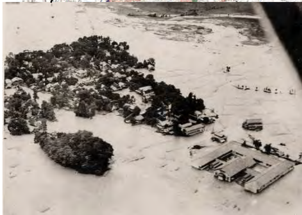
氾濫流にのまれた町の様子(川北町 橘小学校付近) 出典: 尾添川直轄砂防事業五十周年記念誌
