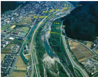
天狗橋付近 (河口より 14.0km)
