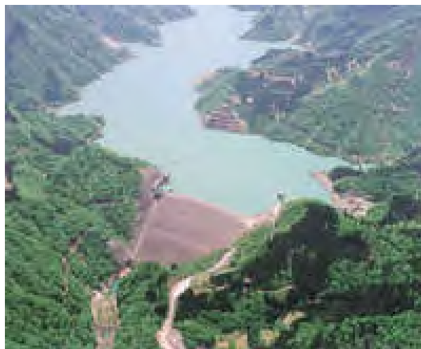
手取川ダム(昭和 53 年完成)
