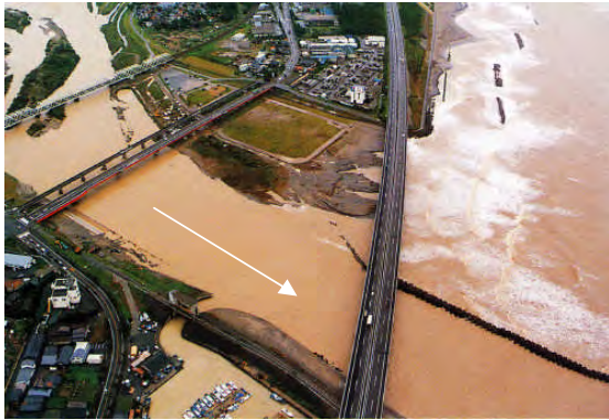
河口の導流堤流出状況
