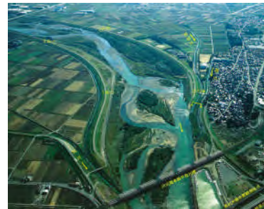
西川・熊田川合流点 (河口より 1.0km 付近)
