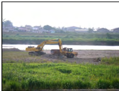
湊地区河道掘削
