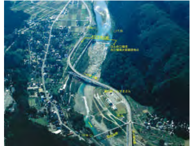
白山合口堰堤付近 (河口より 16.7km)
