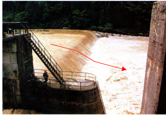
洪水の流出状況(白山合口堰堤)
