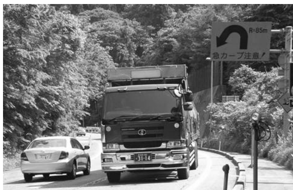
写真②：線形不良箇所 ( R=85\text{m} )
