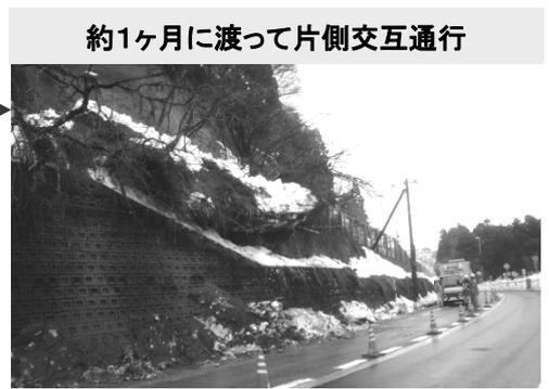
写真: 片掛地区の土砂崩落現場
