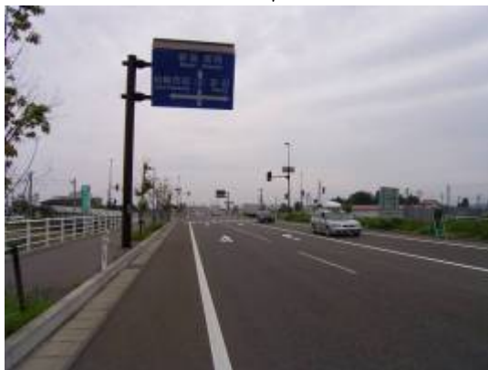
暫定2車線供用中の城東付近の状況 (長岡市方面を望む)平成17年6月
