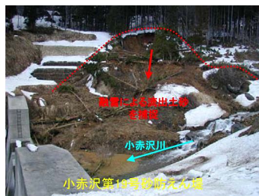
平成14年4月に発生した融雪による崩壊土砂を捕捉 (小赤沢第19号砂防えん堤)
