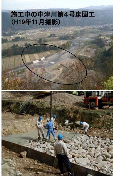
第4号床固工における新粗石コンクリート工法の打設状況
