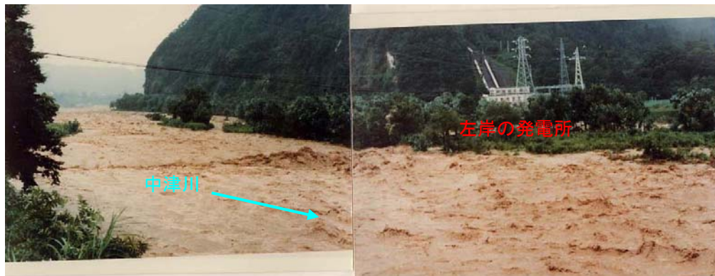
下流域に位置する中津川橋上流付近の出水の状況（昭和56年8月23日）
