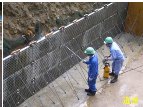
残存型枠を用いたコンクリートの打設状況
