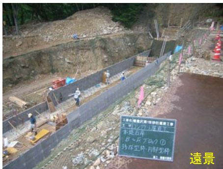
残存型枠を用いたコンクリートの打設状況
