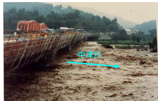
下流域に位置する中津川橋付近の出水の状況（昭和56年8月23日）
