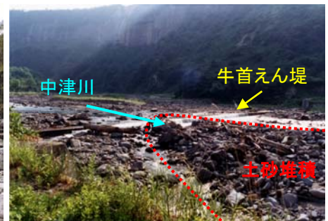
上流からの土砂が堆積する本川下流部 (牛首砂防えん堤下流の土砂堆積状況)
