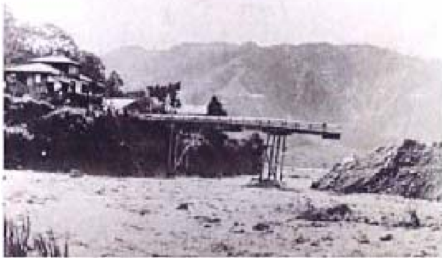
大正3年 中津川橋の倒壊
