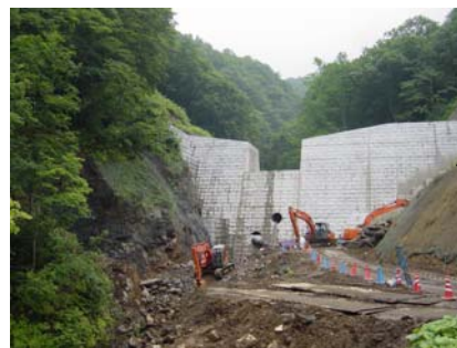
施工中の苗場砂防えん堤 (H19.7.26撮影)
