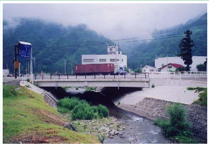
戸沢橋の整備後写真
