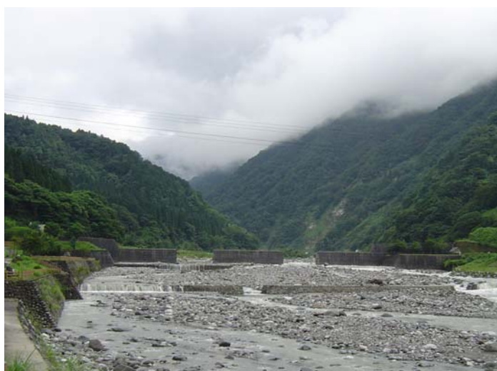
津之浦下流砂防えん堤 中小洪水時に下流に土砂を流す砂防えん堤
