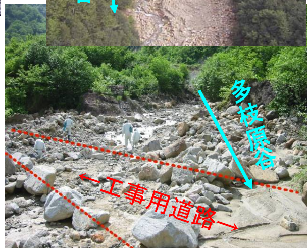
←多枝原谷における土石流捕捉状況 (H15. 8)
