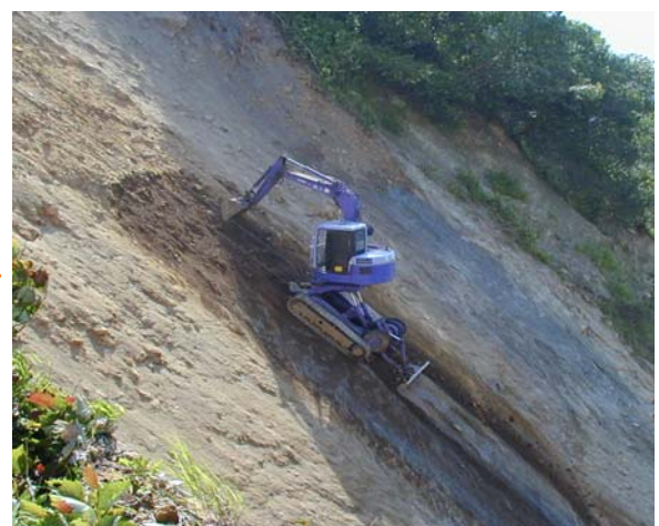
ロッククライミングマシンによる作業状況 (有峰山腹工)
