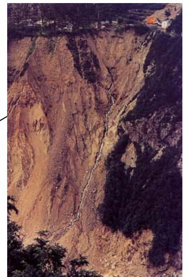
崩壊した水谷平
