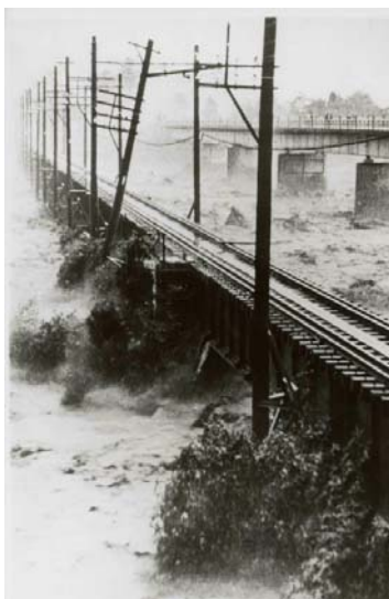
上滝付近の出水状況
