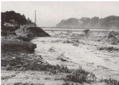
堤防決壊状況
