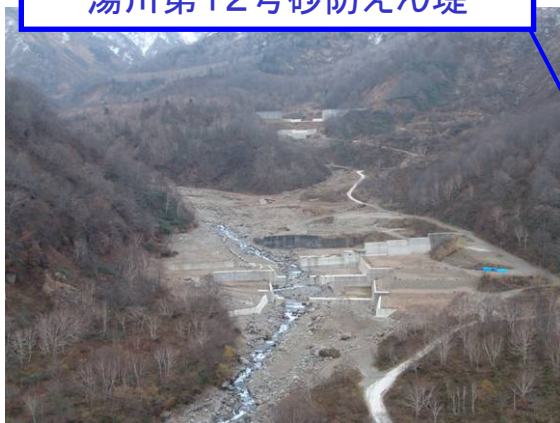
湯川第12号砂防えん堤
