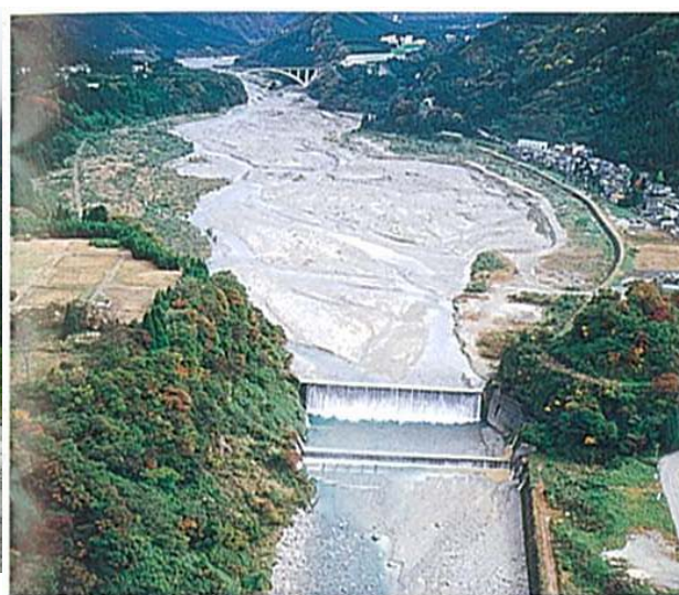
本宮砂防えん堤 日本一の貯砂量を持つ砂防えん堤
