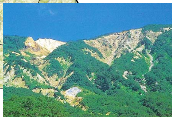
現在でも活発な土砂生産、流出を続ける鳶山崩壊地
