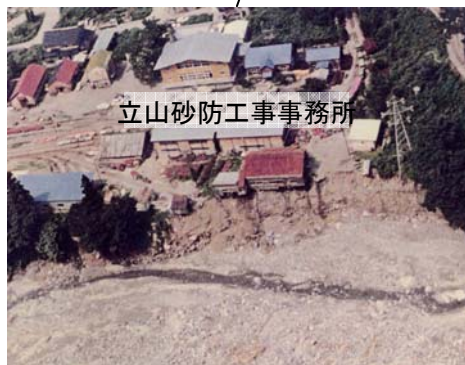
千寿ヶ原被災状況
