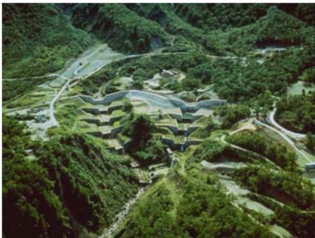
多枝原平砂防施設群(多枝原谷、西谷等) 鳶崩れ直下の砂防えん堤群
