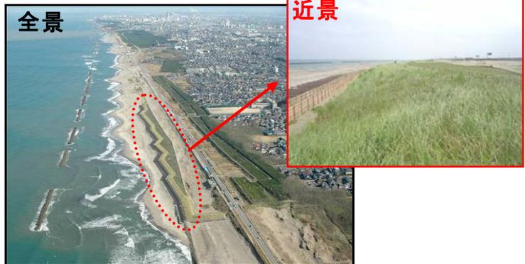
写真－8 海浜植栽による砂浜安定工
