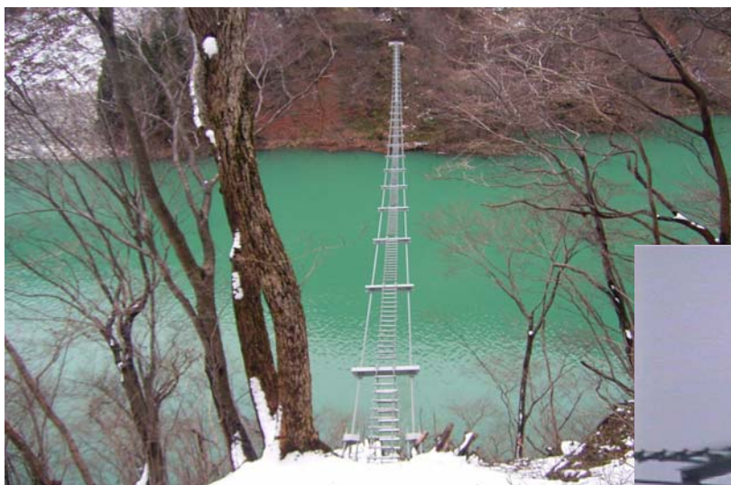
野猿移動用吊り橋完成写真
