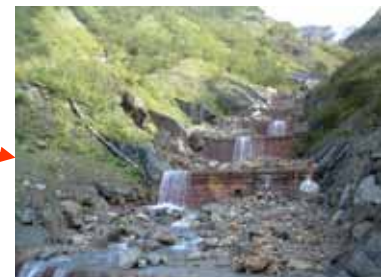
甚之助谷砂防堰堤群
