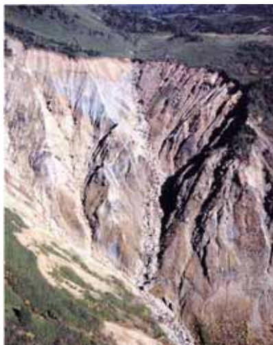
牛首川源頭部の荒廃状況
