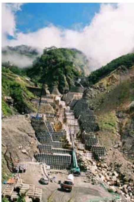
導流落差工の施工状況
