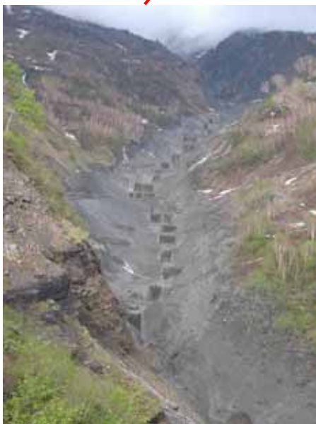
平成16年5月17日 別当谷土石流 連続雨量 217mm 崩壊土砂 約18万m 3 流出土砂 約10万m 3
