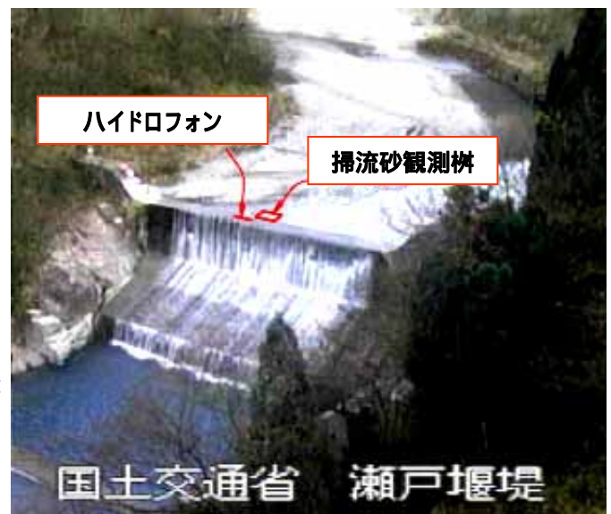
掃流砂観測機器設置状況
