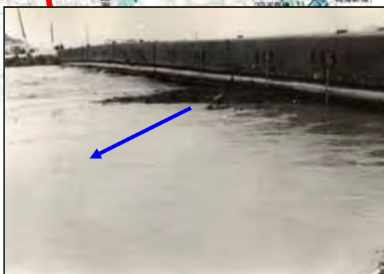
白江大橋地点(左岸より右岸を望む)
