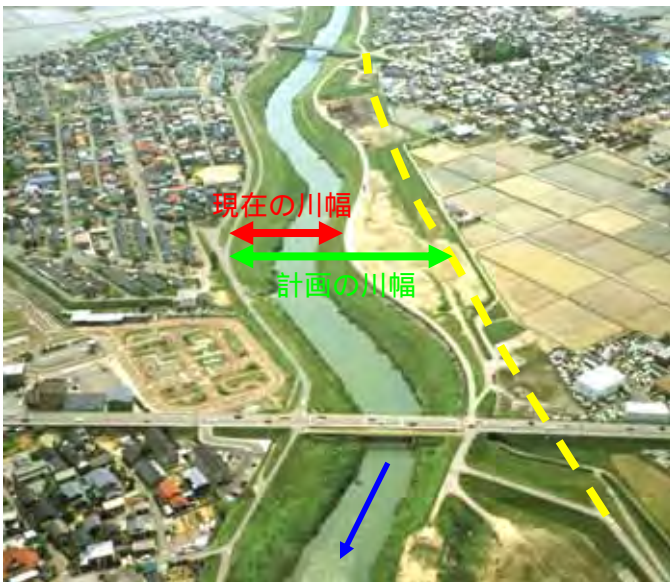
堤防整備が未完成の区間（小松新橋～白江大橋）
