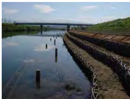
鋼矢板天端を水中部に埋没させた低水護岸
