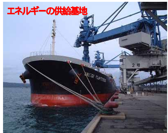
大田火力発電所
